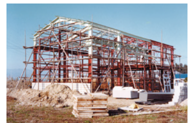
建設中の滋賀営業所
