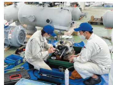
ガスコン作業中
